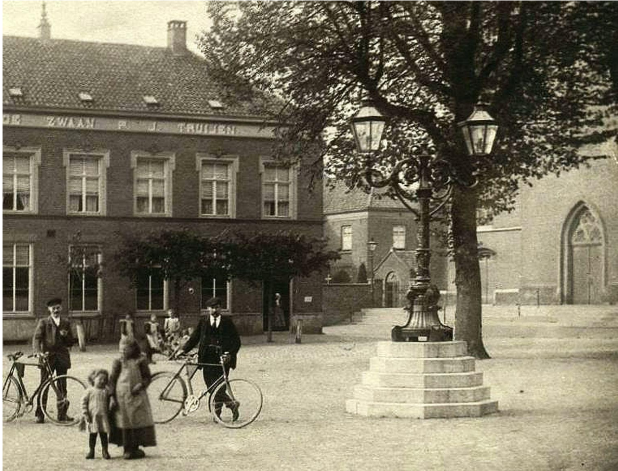
Afb. 3 De Markt rond 1925. Meteen rechts van Hotel De Zwaan is het niveauverschil goed zichtbaar.
